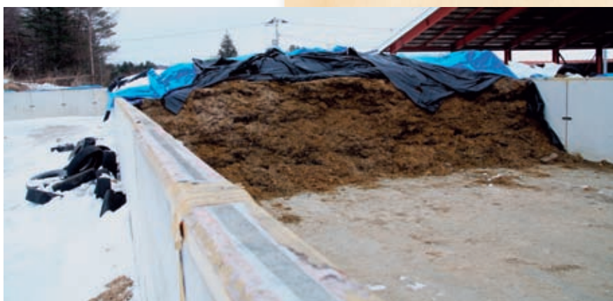
幅10×奥行40×高さ2mのバンカーサイロ。全部で4基設置
