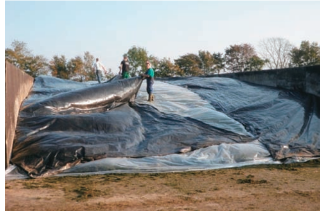
写真6 ビニールシートによるシート掛け
