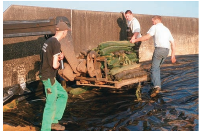
写真7 壁際にはグラベルバッグを隙間なく設置
